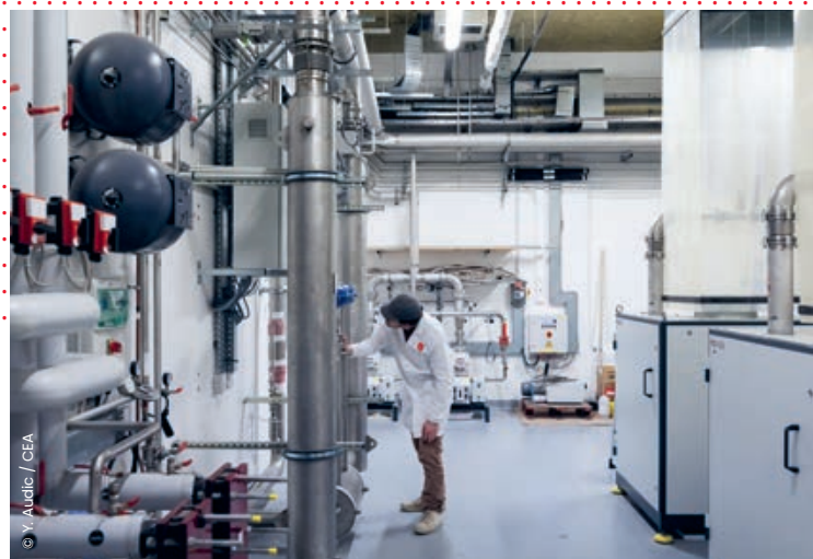
↑ Vue de l'unité cryogénique qui assure le refroidissement constant de l'aimant de l'IRM Iseult à -271^{\circ}\text{C} , grâce à de l'hélium superfluide.
