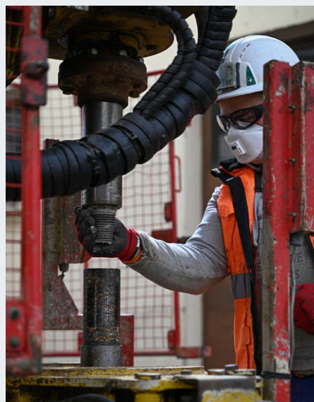
Photo de couverture: Pose de micropieux destinés à l'ETCB (Enceinte de Traitement et de Conditionnement des déchets B) ©CEA-UADF.
