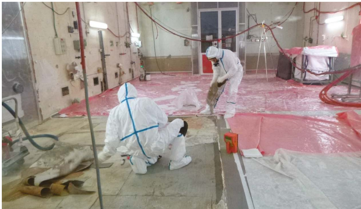
Désamiantage d'un laboratoire bâtiment 18. ©CEA-UADF
