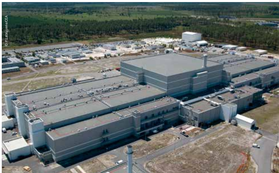
Vue extérieure du bâtiment du laser Mégajoule (LMJ).
