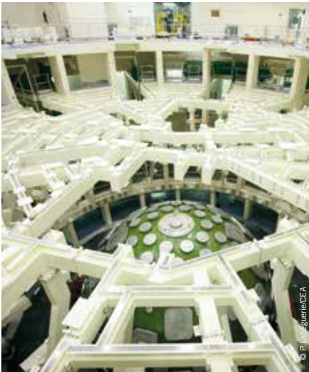
La chambre d'expériences du LMJ en cours d'installation, fin 2010.
